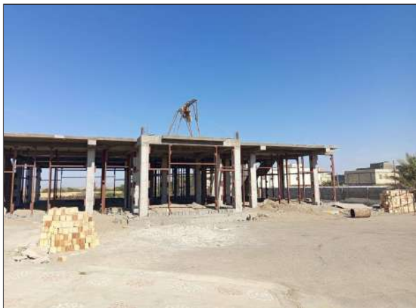
▲ احداث ساختمان سنجش مرکز آموزش فنی و حرفه ای بندر جاسک از محل مسئولیت های اجتماعی وزارت نفت
