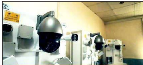
▲ تجهیز کارگاه جوش و خانه هوشمند مرکز آموزش فنی و حرفه‌ای مسجد سلیمان از منابع مسئولیت اجتماعی نفت
